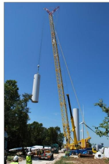
Le premier tronçon de mât est boulonné sur l'insert émergeant du massif béton, puis les tronçons suivants sont assemblés les uns sur les autres.
